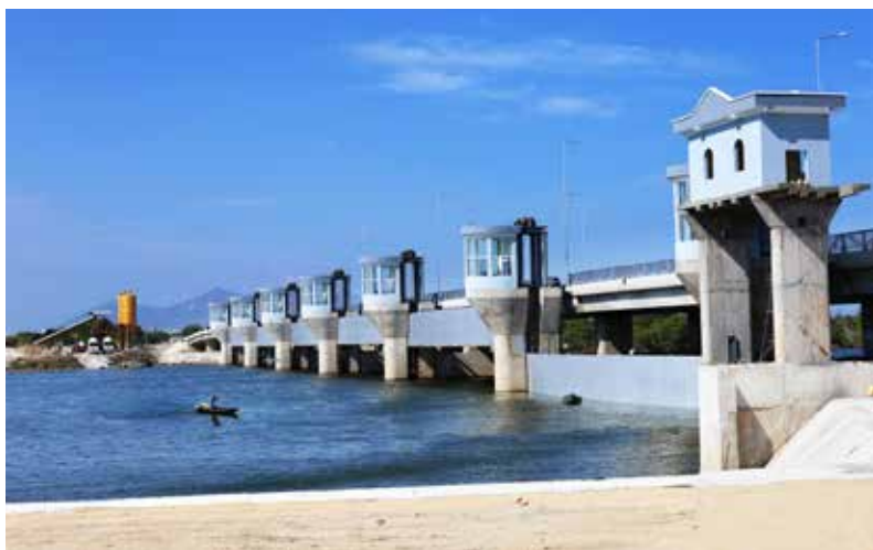
Đập hạ lưu sông Dinh - công trình thủy lợi kết hợp giao thông, nối liền thành phố Phan Rang - Tháp Chàm và huyện Ninh Phước
